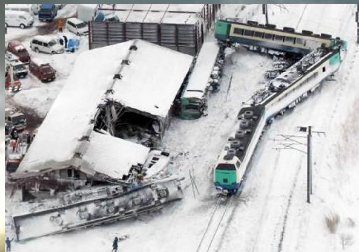
庄内平野での竜巻による列車 脱線事故 (2005年12月)
