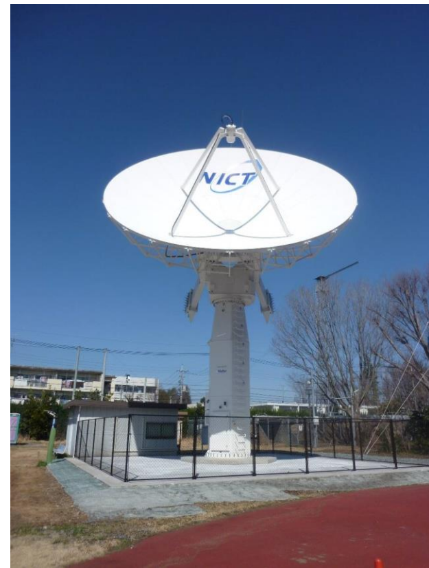
太陽風観測データ受信システム
