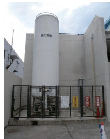
高圧ガス保安法対象の液化窒素 CE 装置
