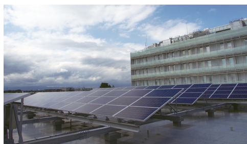
ミリ波棟屋上の太陽電池
