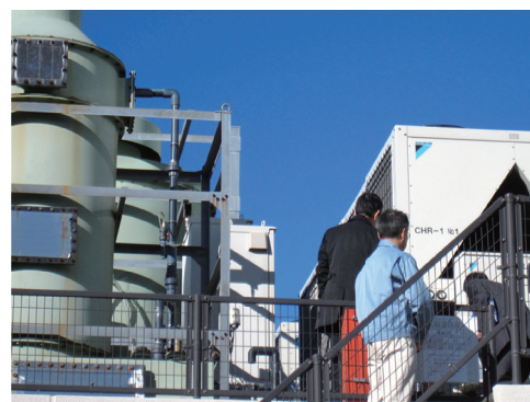
空調機確認の様子
