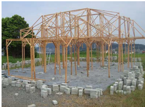
図8 シールドテント骨組み
