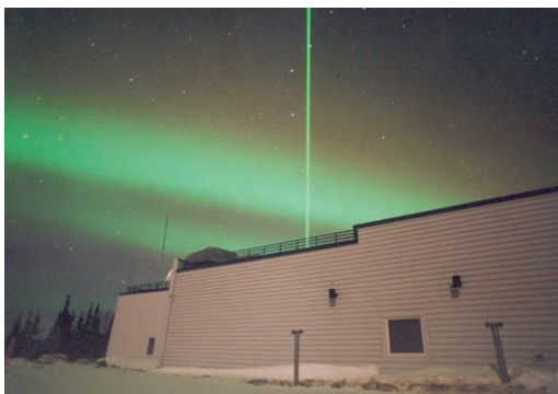
図2.15.1 アラスカのポーカーフラット実験場のライダー棟
