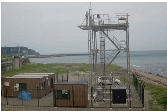
図2.17.15 上越市に整備された船舶レーダー試験設備
