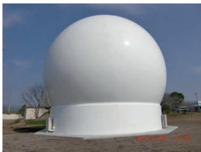
図2.15.18 平成26年3月に山川電波観測施設に完成した太陽電波観測システム
