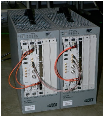
図2.17.14 レーダースプリアス高速計測装置
