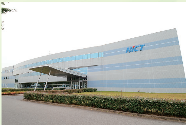
●神戸研究所未来ICT研究センター 第一研究棟
