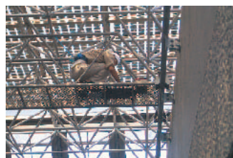
図2●フーコーの振り子の支点を取り付けているところ。作業しているのは小室純一主幹
