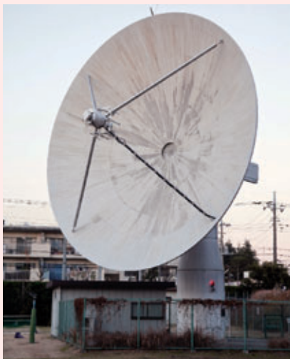
図5●NICT本部の敷地内には、ACE衛星からのリアルタイムデータを受信するパラボラアンテナが設置されている
