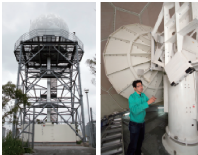
図3●降雨レーダのレドーム(左)と、内部に設置されたレーダ(右)
