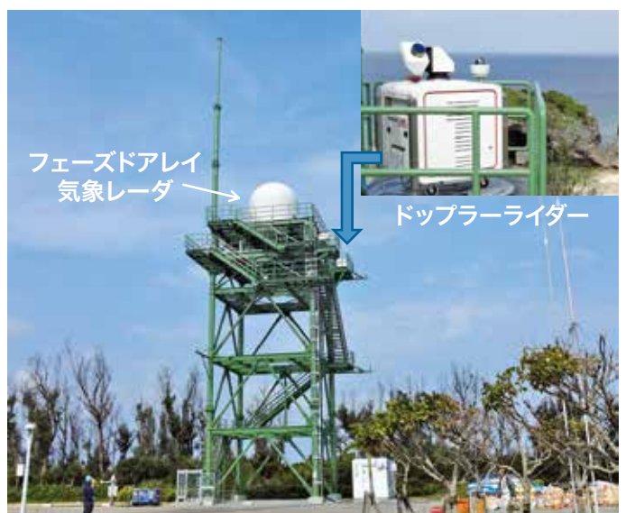
図4 フェーズドアレイ気象レーダ・ドップラーライダー融合システムとして沖縄に設置されたドップラーライダー
