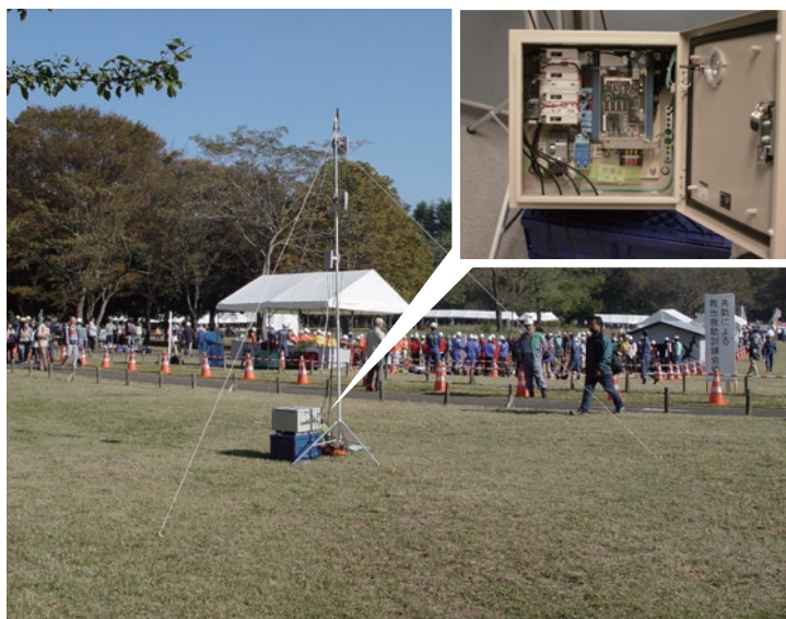
図2 ノード実証機と平成23年度東京都・小平市・西東京市・武蔵野市・小金井市合同総合防災訓練(都立小金井公園)での臨時ネットワーク構築の様子
