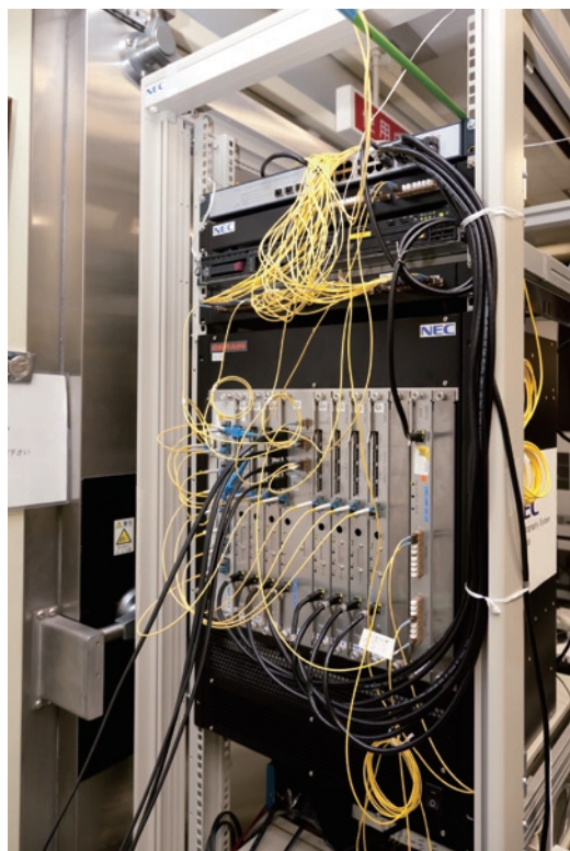
図3 量子暗号ネットワーク監視装置 一般に普及するためには、小型化する必要がある。
