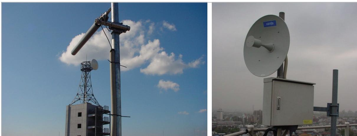
図2 消防研究所(左)とNICT(右)に設置した長距離無線LANアンテナ
