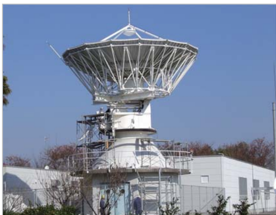
図2 WINDS 基準局アンテナ部外観
