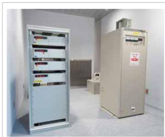
図2 セシウム原子時計と水素メーザ周波数標準器
