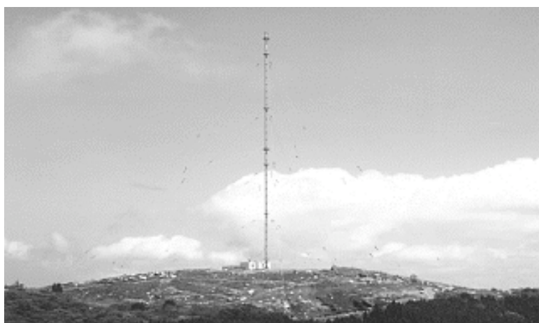
はがね山標準電波送信所（佐賀・福岡 県境）と地上高200mの空中線
