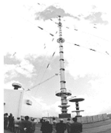
はがね山標準電波送信所（佐賀・福岡 県境）と地上高200mの空中線
