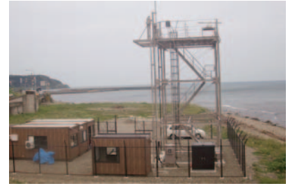
図6 沿岸型式検定試験施設
