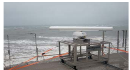
図6 沿岸型式検定試験場
