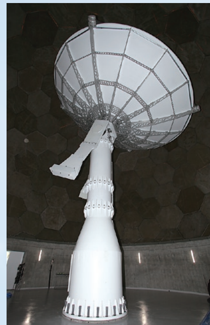
太陽電波観測システムのドーム内アンテナ
