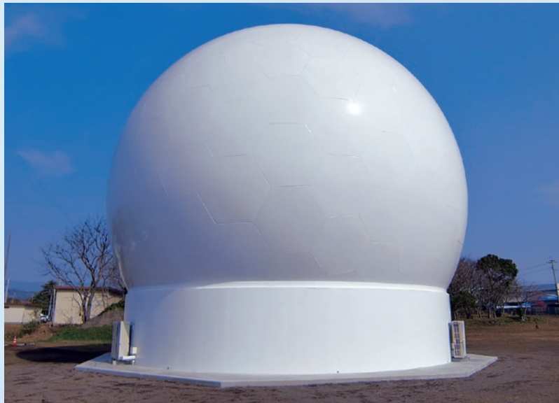
太陽電波観測システムの外観
