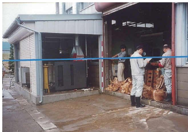
図5 沢山川流域での浸水被害状況(1999年8月)〔千曲市提供〕 写真中の青色線は、浸水があった高さを示しています。
