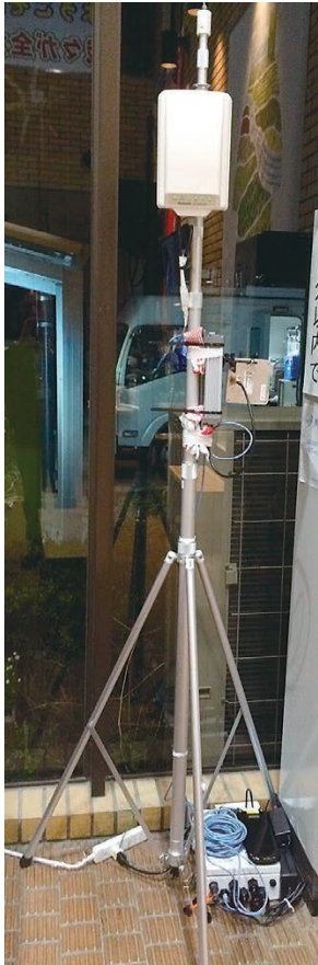
図2 現場に設置されたNerveNet
