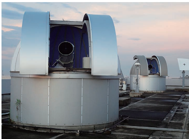
図1 研究本館屋上の2台のドーム
