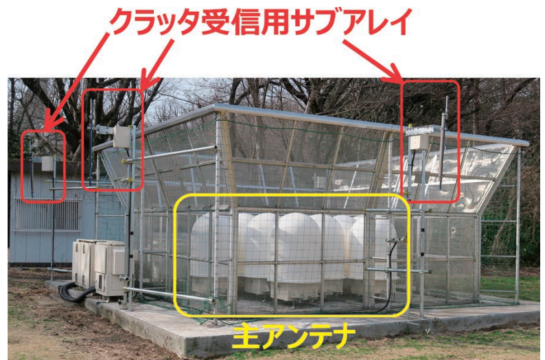
図3 LQ-13に設置されたアダプティブクラッタ抑圧システムの外観
