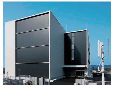
図2 助成金により整備されたサーバ等が設置されたデータセンター（提供：株式会社両備システムズ）
