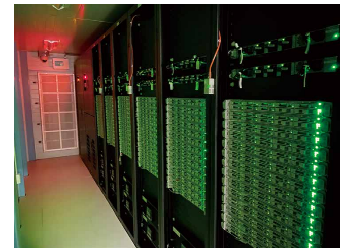
北陸StarBED技術センターにて運用中のCy02コンテナ型データセンタ内部写真
