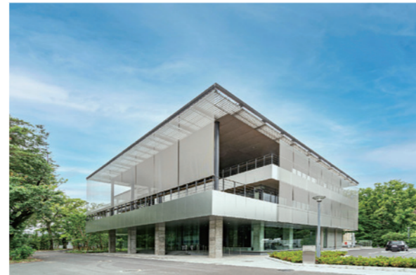
写真1 令和4年に新設された協創棟の外観
