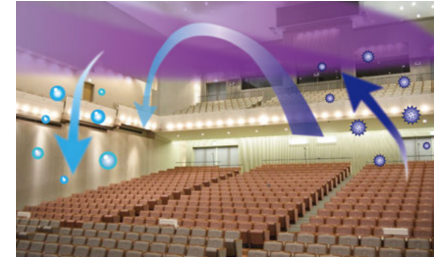
▲大空間中の浮遊ウイルスを高速・安全に不活性化する深紫外LEDシステム
