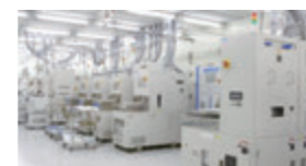
神戸クリーンルーム内の装置
