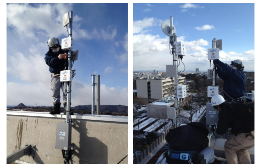
東北大学(仙台市)構内に整備した 実証実験用基地局
