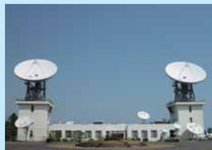
向かって右手がCS(通信衛星) 左手がBS(放送衛星)の実験棟
