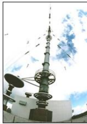
はがね山標準電波送信所の 送信鉄塔基部
