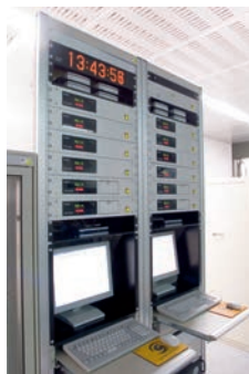
図2.16.3 日本標準時の供給システム
