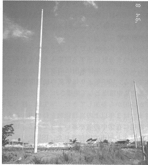
▲写真1 送信用のアンテナ (高さ:30m、大きさ:78m×78m)
