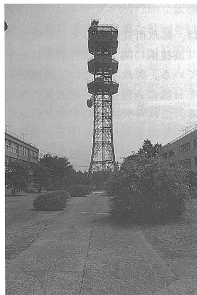
▲写真2 移動通信用鉄塔
