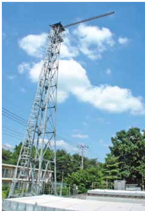
図1 20m落下鉄塔
