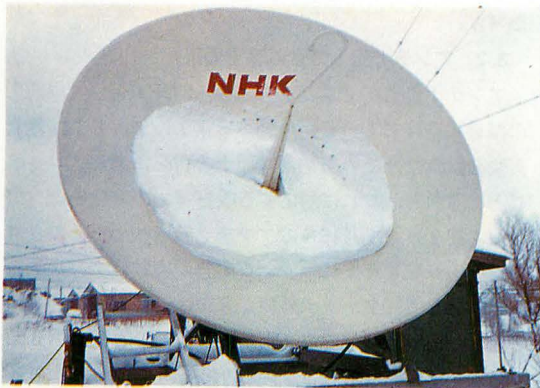
c. 1月16日のアンテナ積雪を同心円に50cm除雪した状態
