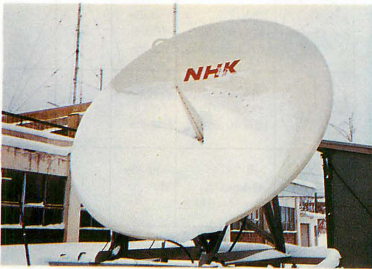
a. 1月16日のアンテナ着雪状態最深16cm
