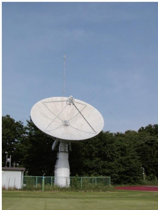
図2 ACE衛星からのリアルタイム太陽風データを受信しているNICTのアンテナ
