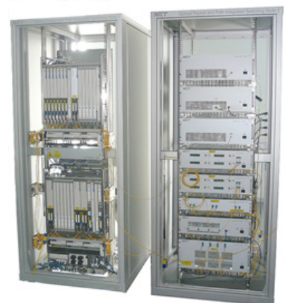
図2 光パケット・光パス統合ノード写真
