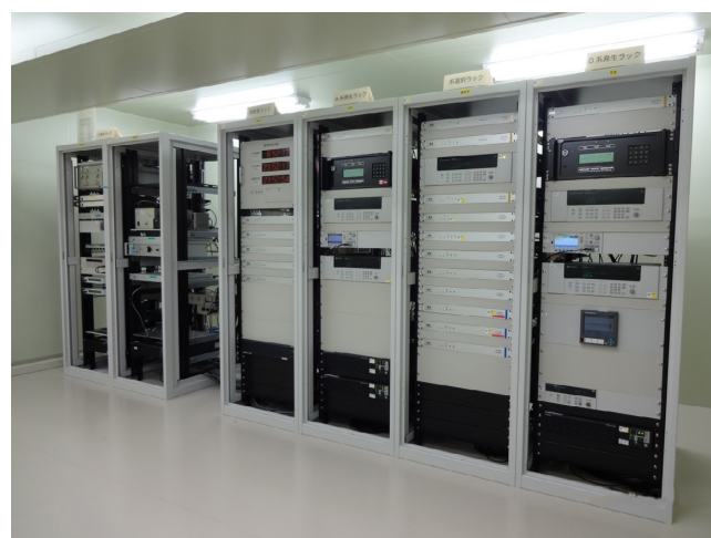
図 2 神戸副局の原子時系発生システム、計測システム、時刻比較システム
