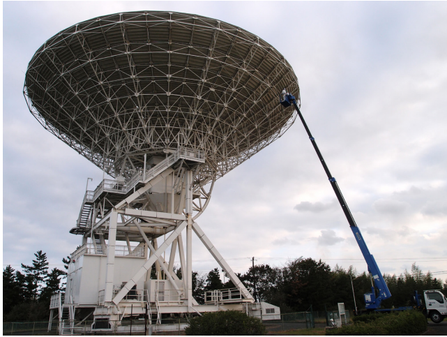
図6 高所作業車による背面構造部の腐食調査
