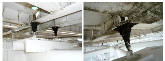
図5 ナットプレートへのユウレカ塗布(左)、ユウレカ塗布約11年後(右)
