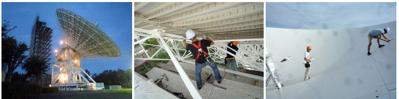
図7 ホログラフィ観測中の34mアンテナ 左は主鏡背面構造部でパネル調整を行うための仮設足場(左)、仮設足場上でのパネル調整ボルト清掃・鏡面調整(中)、反射鏡表面側からのパネル調整(右)
