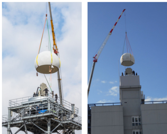
図 1 神戸市の NICT 未来 ICT 研究所 (左) と吹田市の大阪大学 (右) に設置された MP-PAWR
