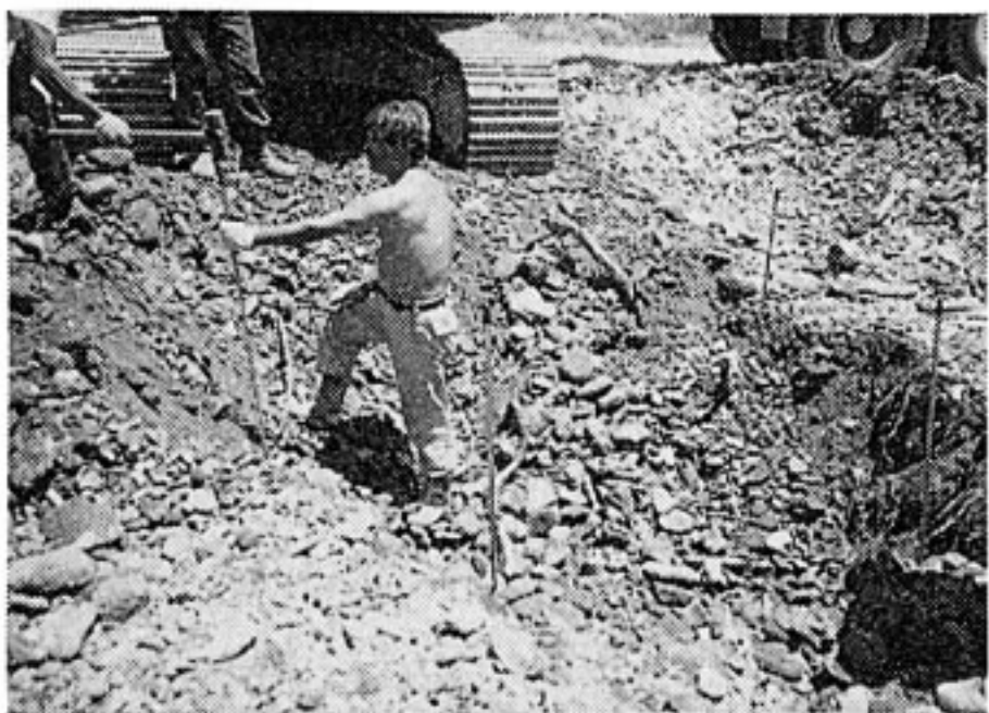
第17図 アース棒の打ち込み 打ち込めば幾らでも入る。
