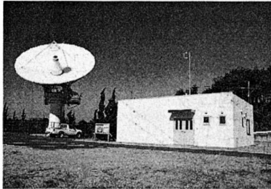
第 3 図 鹿嶋副中央局（観測局舎）の外観
