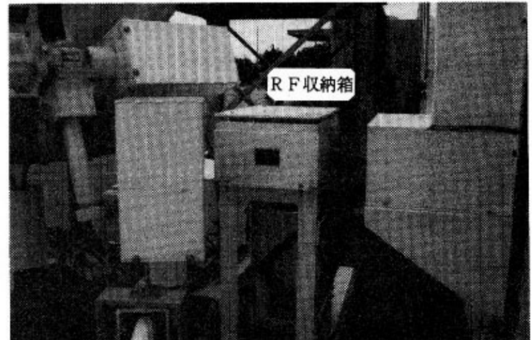
第21図 RF収納箱の設置状況
