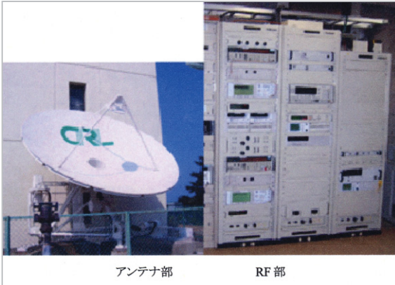
図1 Ka帯フィーダリンク局外観
