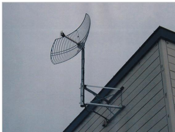
図12 宗谷中学校に設置した長距離無線LANパラボラアンテナ
