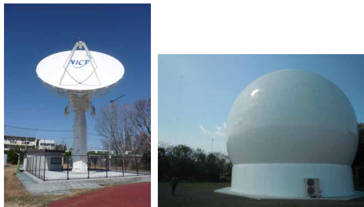
図 4 NICT 本部(小金井市)に設置された太陽風観測衛星データ受信システム(左)及び、山川電波観測施設に設置された太陽電波観測システム(右)。
