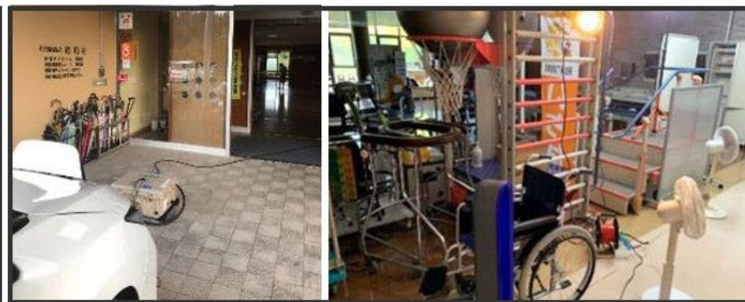
■ 高齢者福祉施設 (扇風機、冷蔵庫、調理器具の稼働)
