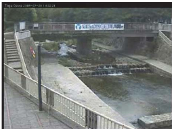
都賀川水難事故（平成20年）
