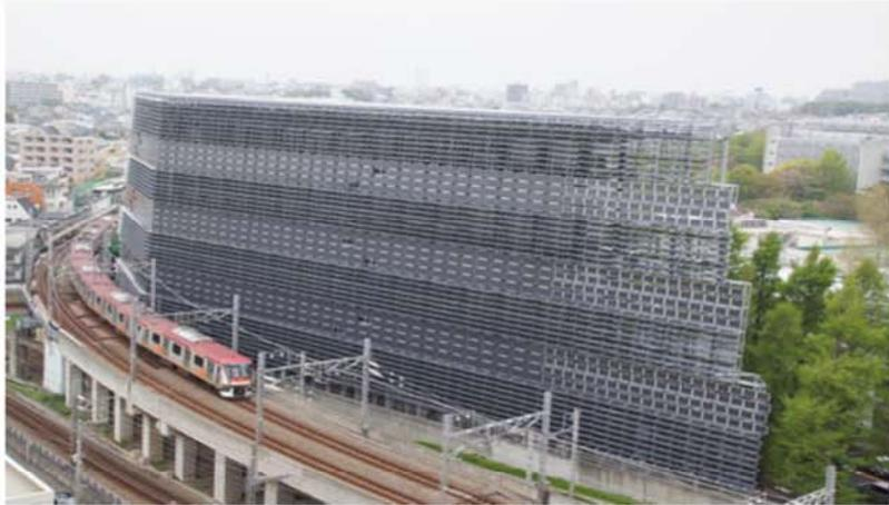
東京工業大学の大岡山キャンパスの「環境エネルギーイノベーション棟」。南側と西側の壁面に加えて、屋上に合計で4570枚の太陽光発電パネルを設置。太陽光発電パネルによる電力で不足する場合は燃料電池を利用して電力をまかなう。
